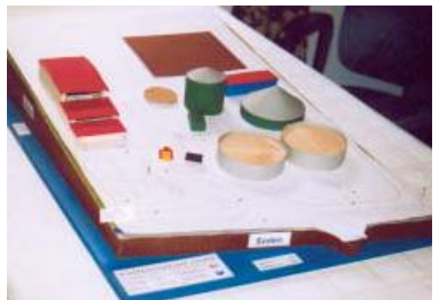
Das Modell der Bioanlage, deren Herzstück der Fermenter ist, das hohe grüne Gebäude in der Mitte. Die roten Dächer links beherbergen Blockheizkraftwerk und Holzhackschnitzelheizwerk.
